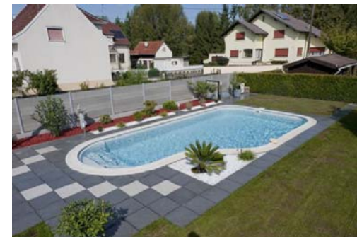
Entretien au sel (Electrolyseur)
